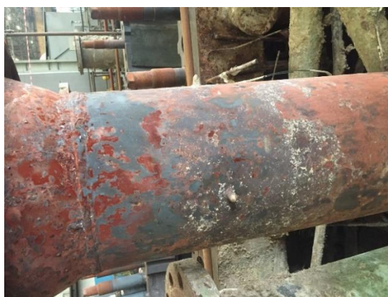
Рис. 1. Теплоэнергетическое оборудование, подвергшееся коррозии
