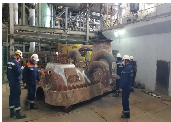
Рис. 1. Теплоэнергетическое оборудование, подвергшееся коррозии
